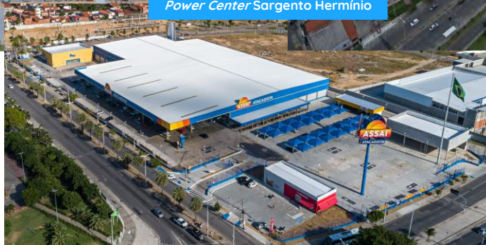
Power Center Sargento Hermínio
